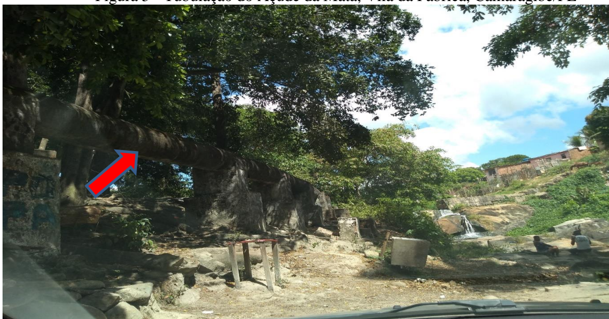
Figura 5 - Tubulação do Açude da Mata, Vila da Fábrica, Camaragibe/PE
