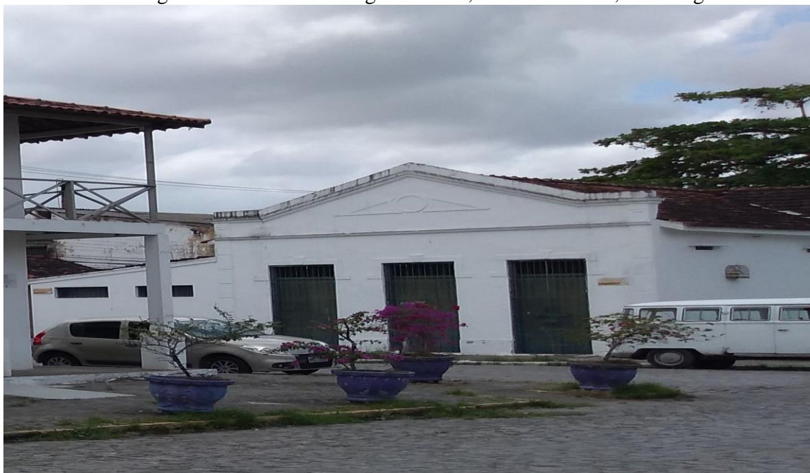
Figura 16 - Prédio do antigo barracão, Vila da Fábrica, Camaragibe/PE
