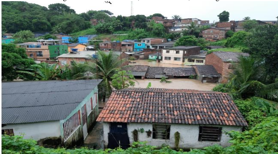
Figura 21 - Enchente 2022, Vila da Fábrica, Camaragibe/PE
