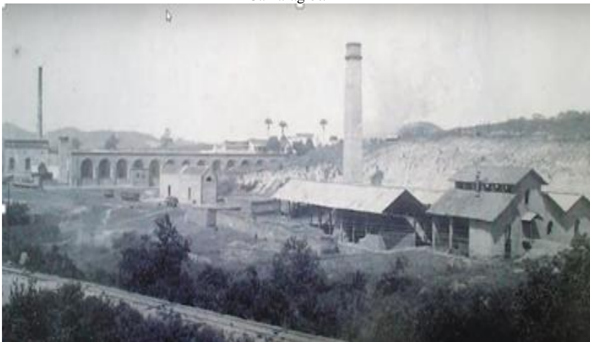
Figura 22 - Estrada de Ferro séc. XX em frente à Indústria Têxtil, Vila da Fábrica, Camaragibe/PE
