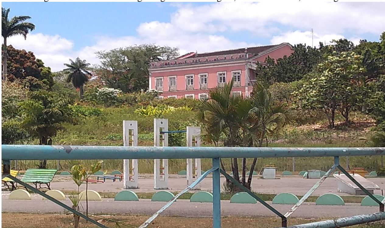
Figura 4 - Casarão do antigo Engenho Camaragibe, Vila da Fábrica, Camaragibe/PE
