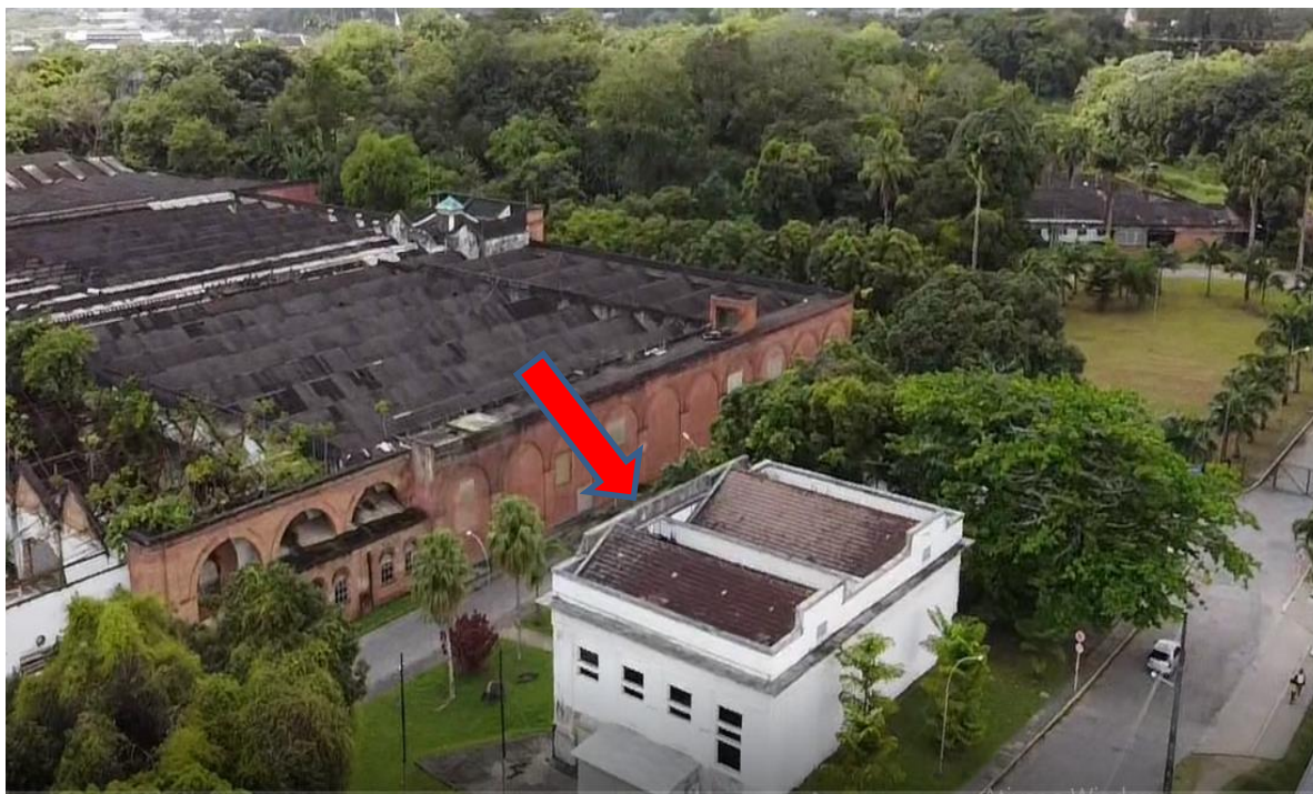
Figura 27 - Prédio da antiga usina elétrica, Vila da Fábrica, Camaragibe/PE
