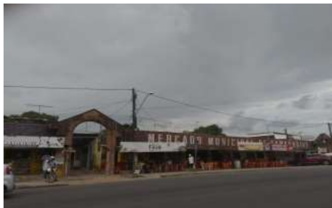
Figura 16 - Vista dos arcos do antigo mercado
